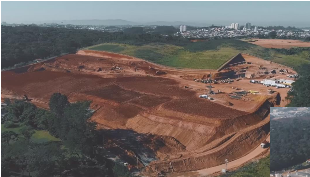
* Início da terraplenagem
